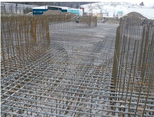
Ferrailage de silos - ALFACON SRL
